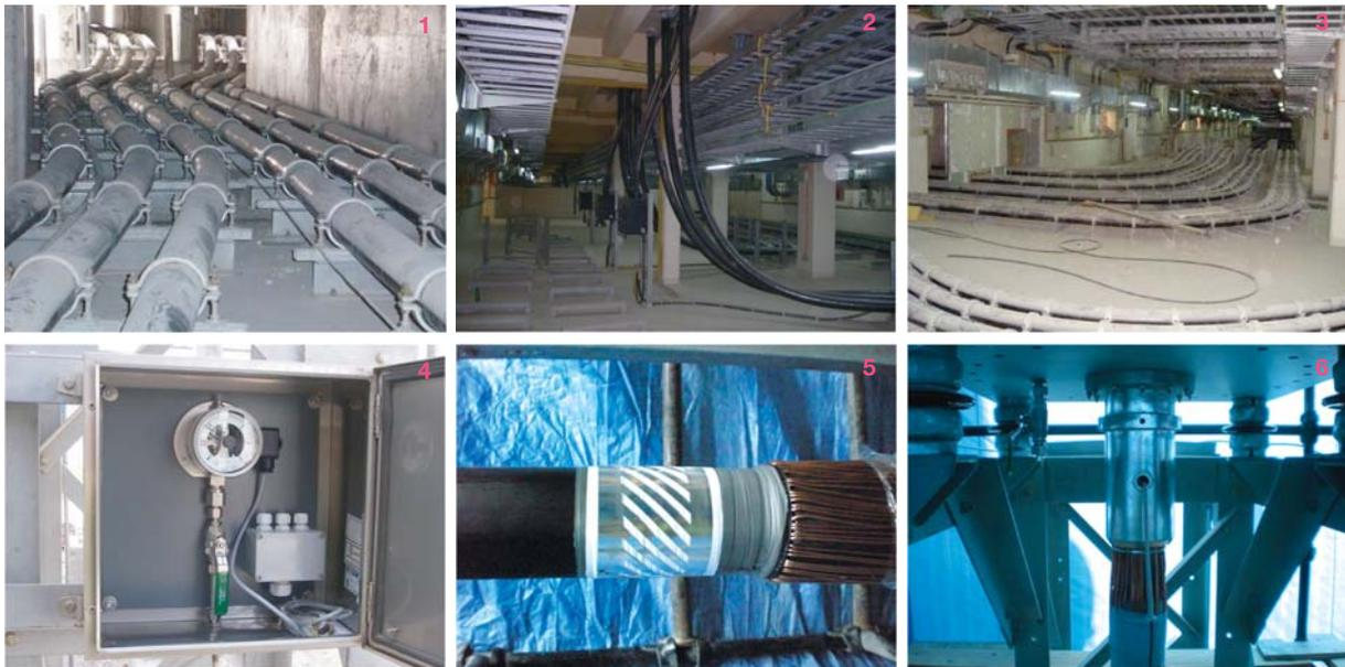
1. Entrada al sótano Edificio GIS 400 kV; 2. y 3. - Detalle cables en el sótano GIS 400 kV; 4. Detalle manómetro terminal exterior OTP-420; 5. y 6. Detalle instalación sensor capacitativo medida descargas parciales.
