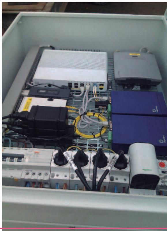
Foto izquierda: En extremo origen se facilita la conexión eléctrica mediante CETAC M/H trifásico de 32 A y conexión de datos mediante conector robusto de rosca y estándar LC para F.O. monomodo, con lo que las operaciones de puesta en servicio y desconexión son sumamente sencillas.
